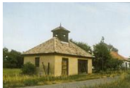
Budova bývalej hasičskej zbrojnice v Peťove
